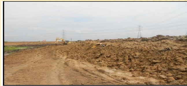
Fill Embankment & compact El.+ 2.90 m.
